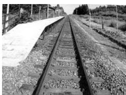
铁轨铺在枕木上 B
