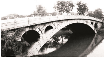
图一 安济石桥日月留 _____是世界上保存完好、最古老的一座石拱桥。
